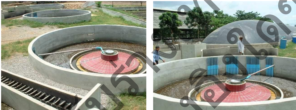
รูปที่ 5.2 ระบบผลิตก๊าซชีวภาพแบบยูเอเอสบี (UASB)
