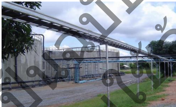
รูปที่ 5.4 ระบบผลิตก๊าซชีวภาพแบบถังกรองไม่ใช้อากาศ (Anaerobic Filter or Anaerobic Fixed Film)
