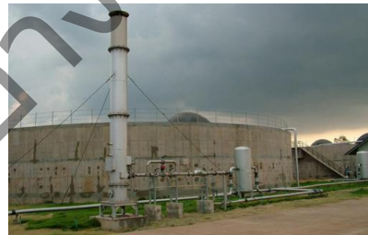
รูปที่ 5.4 ระบบผลิตก๊าซชีวภาพแบบถังกรองไม่ใช้อากาศ (Anaerobic Filter or Anaerobic Fixed Film)
