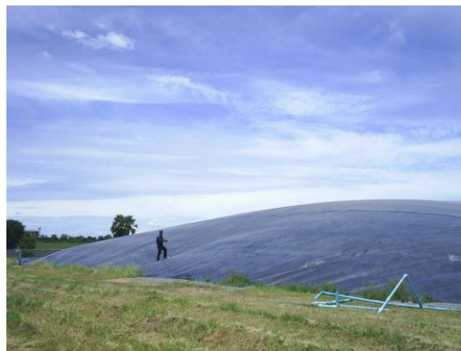
รูปที่ 5.5 ลักษณะ Anaerobic Covered Lagoon
